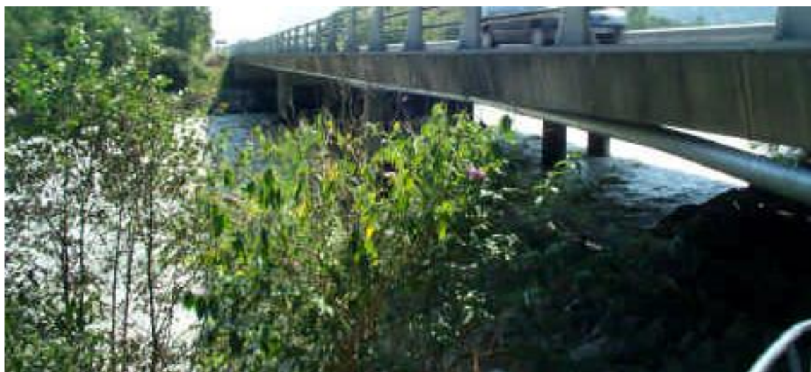
Photo 1 : Exemple de traversée de pont par encorbellement
